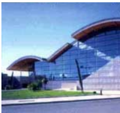
Centre Nautique de Sète Architecte : F. COSTE – M. CARDUNER Concepteur Gammiste : KAWNEER
