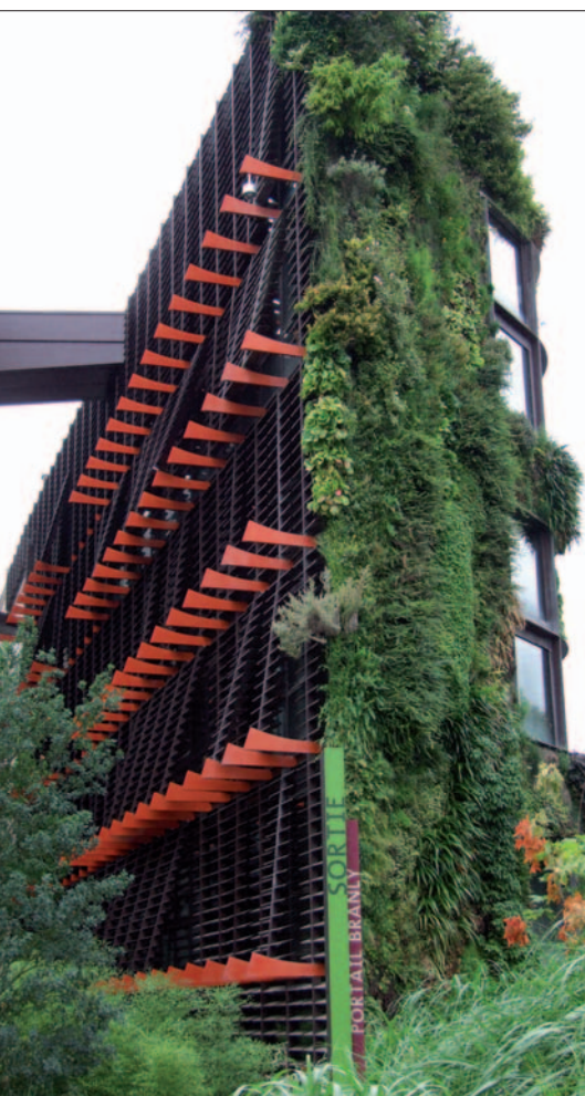
Architecte Jean Nouvel ; doc. DuPont
