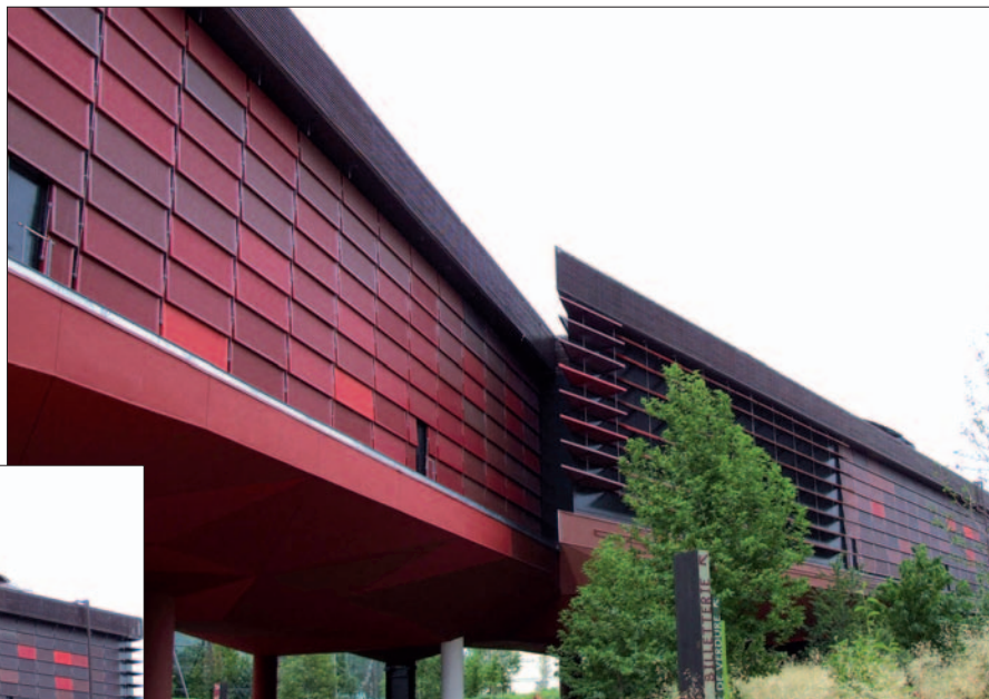
Architecte Jean Nouvel ; doc. DuPont
